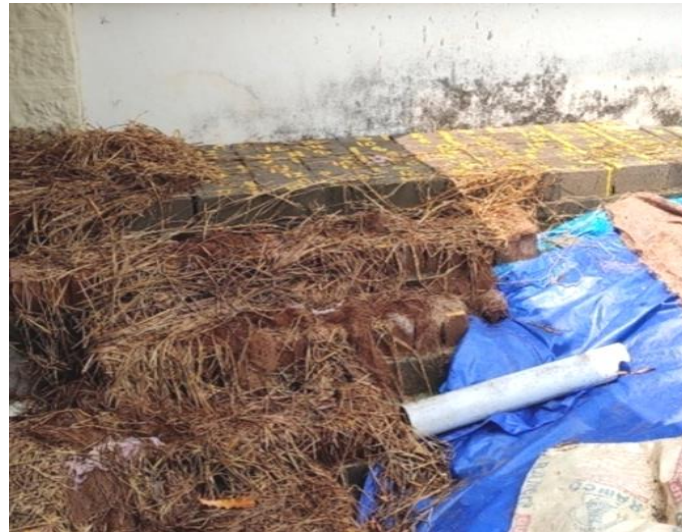
Fig. 7.3 Curing of CSEBs
